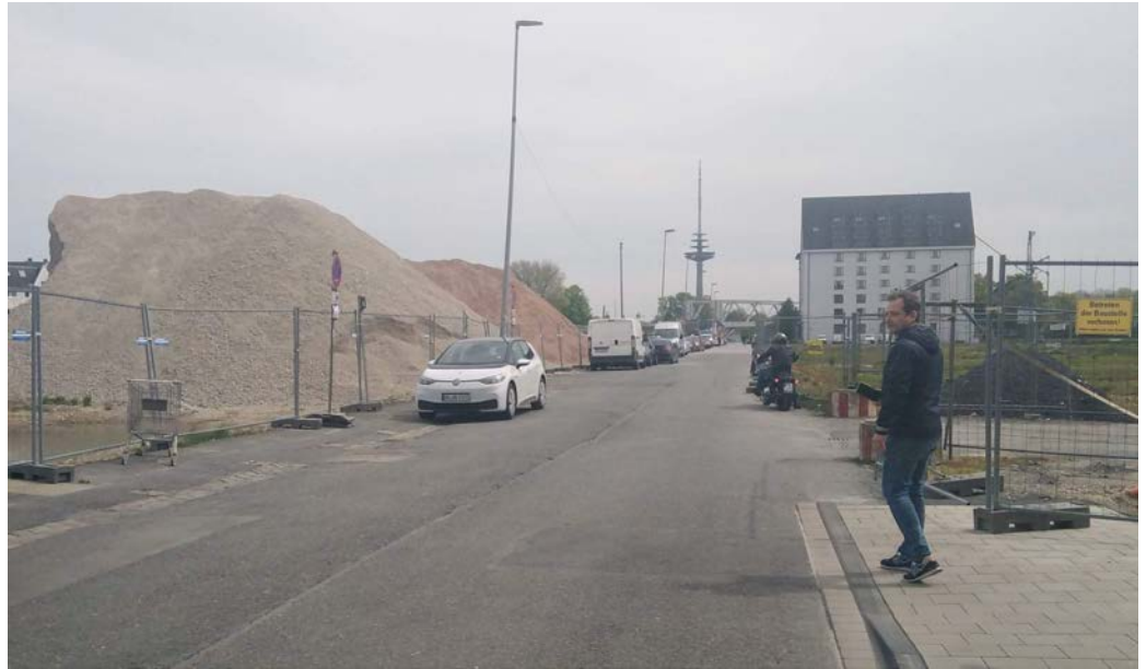
Abbildung 26: Ende des Gehwegs am Hafenweg.
