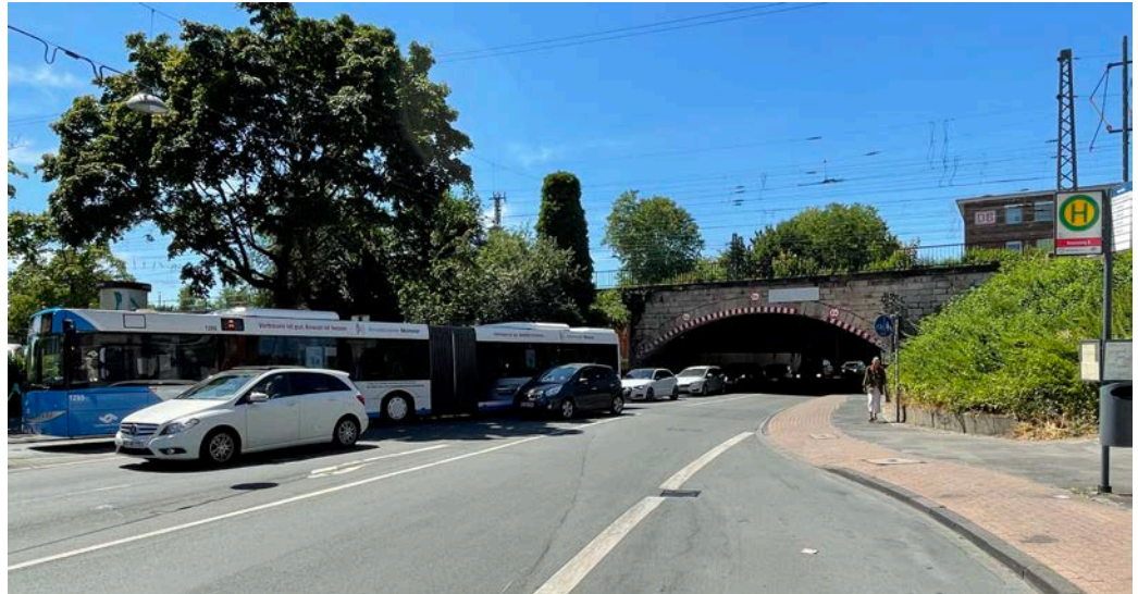
Abbildung 22: Unterführung der Bahngleise auf der Hafestraße.
