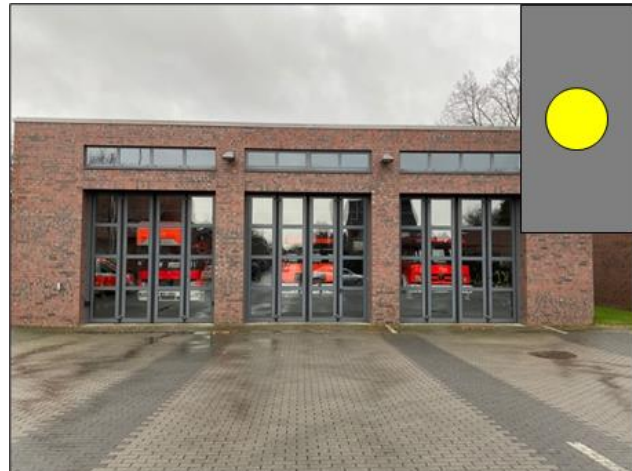
Abb. 53: Feuerwehrhaus FF Mecklenbeck (Quelle Bildmaterial: Lülf+)
