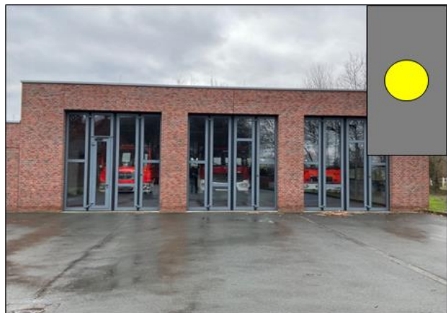
Abb. 61: Feuerwehrhaus FF Werse-Laer (Quelle Bildmaterial: Lülf+)
