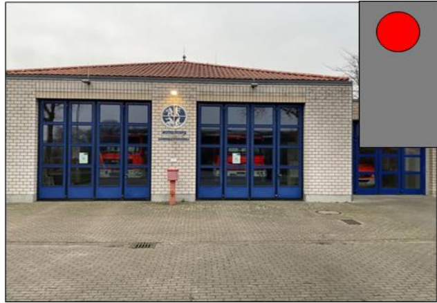
Abb. 56: Feuerwehrhaus FF Hager-Uhlenbrock (Quelle Bildmaterial: Lülf+)
