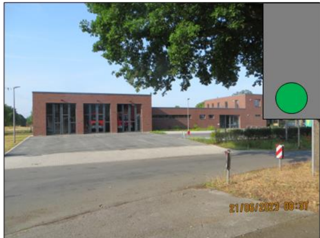
Abb. 57: Feuerwehrhaus FF Sprakel (Quelle Bildmaterial: Fw Münster)
