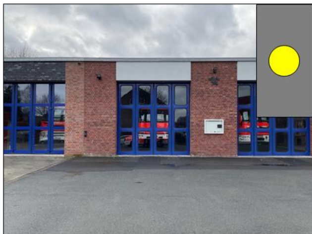
Abb. 51: Feuerwehrhaus FF Gremmendorf (Quelle Bildmaterial: Lülf+)
