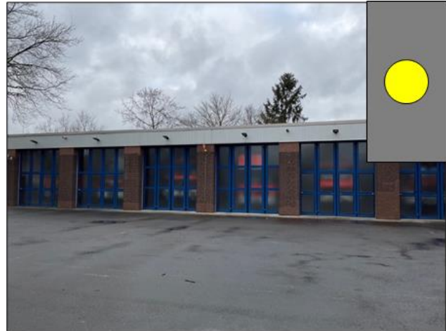
Abb. 64: Feuerwehrhaus FF Hiltrup (Quelle Bildmaterial: Lülf+)
