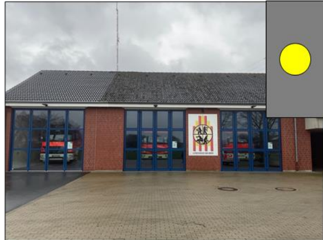
Abb. 58: Feuerwehrhaus FF Gelmer (Quelle Bildmaterial: Lülf+)
