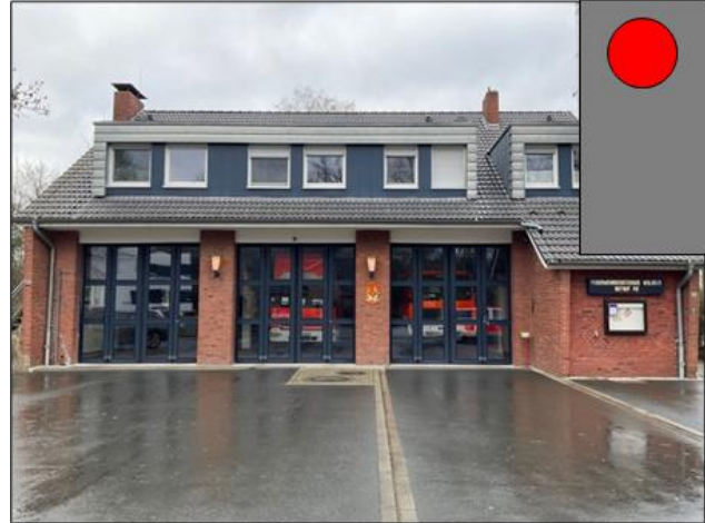
Abb. 62: Feuerwehrhaus FF Wolbeck (Quelle Bildmaterial: Lülf+)
