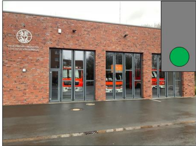
Abb. 50: Feuerwehrhaus FF Kinderhaus (Quelle Bildmaterial: Lülf+)
