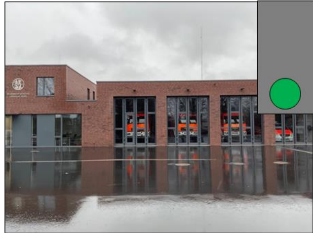
Abb. 54: Feuerwehrhaus FF Roxel (Quelle Bildmaterial: Lülff+)
