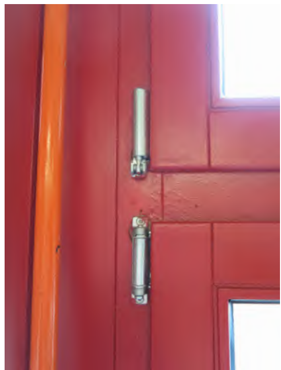
Abb. 09 Musterfenster: Neue Fensterbeschläge
