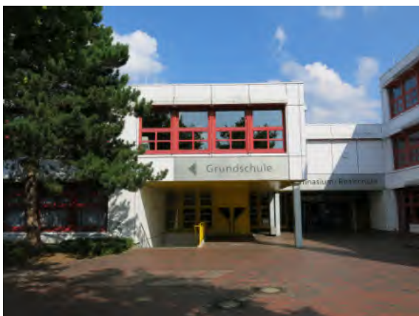
Abb. 01 Haupteingang Schulzentrum Kinderhaus
