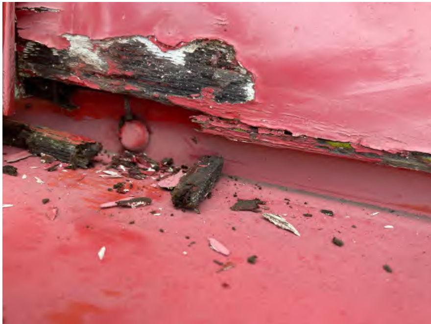
Abb. 17 Zustand Bestandsfenster
