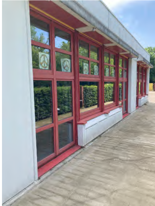
Abb. 18 Bodentiefe Elemente Mensabereich
