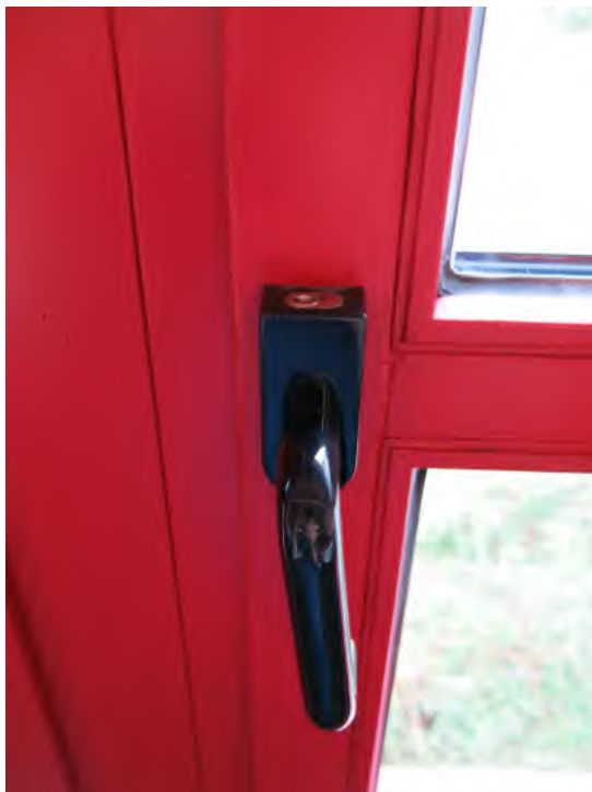
Abb. 08 Musterfenster, Fenstergriff Abschließbar Kunststoff schwarz (Hersteller: HEWI)
