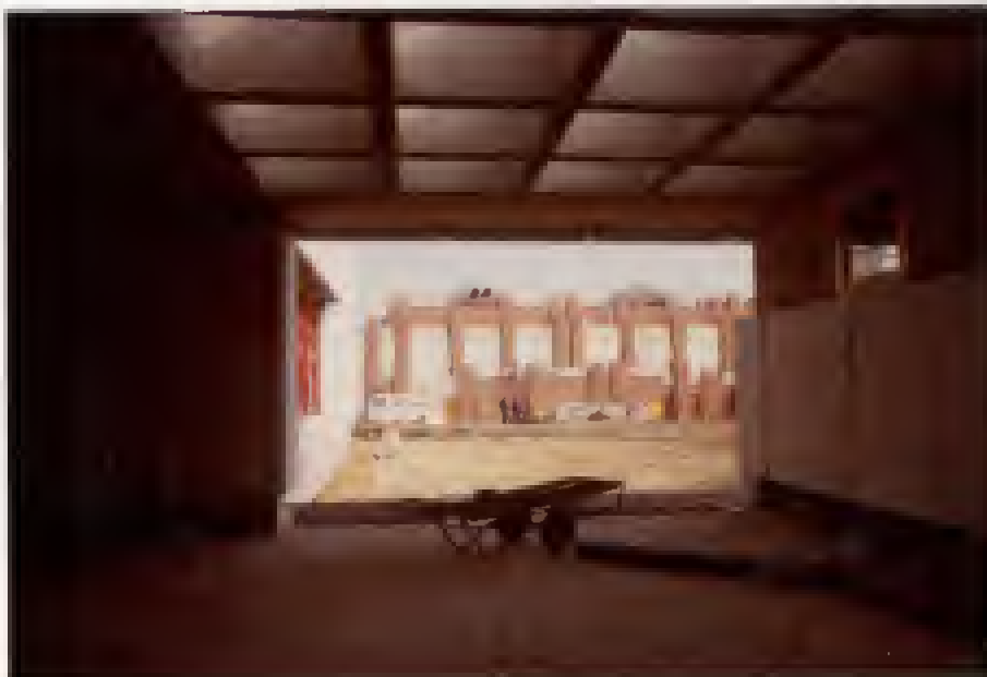
Abb. 24 Bauzeitliche Aufnahmen der Baustelle
