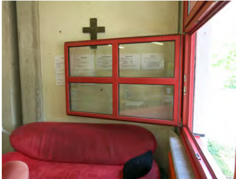
Abb. 04 Große Öffnungsflügel mit tiefem Raumeinstand in den Innenraum
