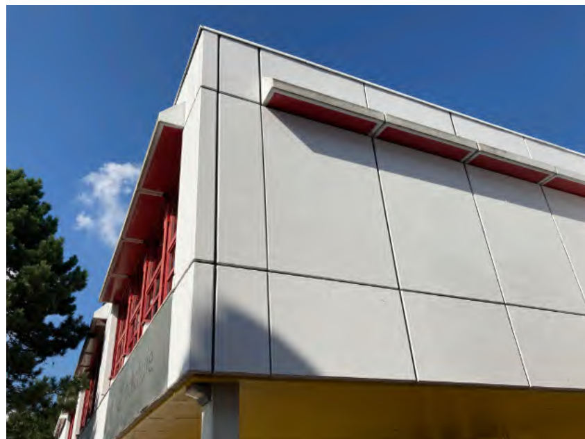
Abb. 21 Situation Außenecke Fassade
