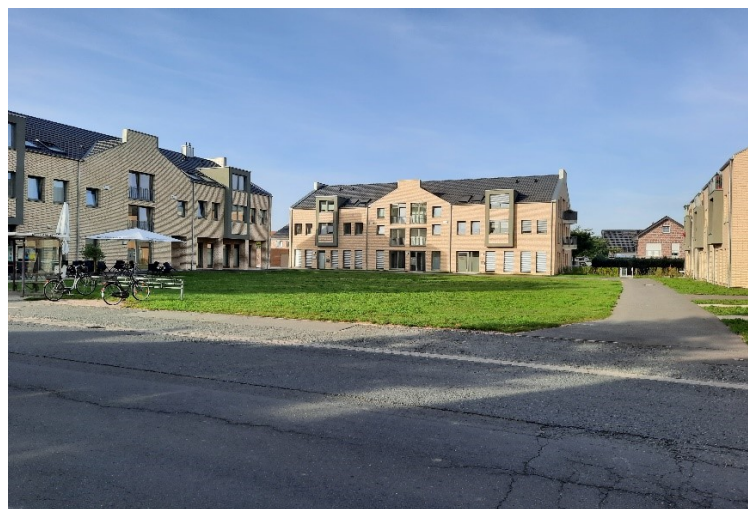
Foto, Blick von Osten (Sprakeler Straße) auf den Platz
