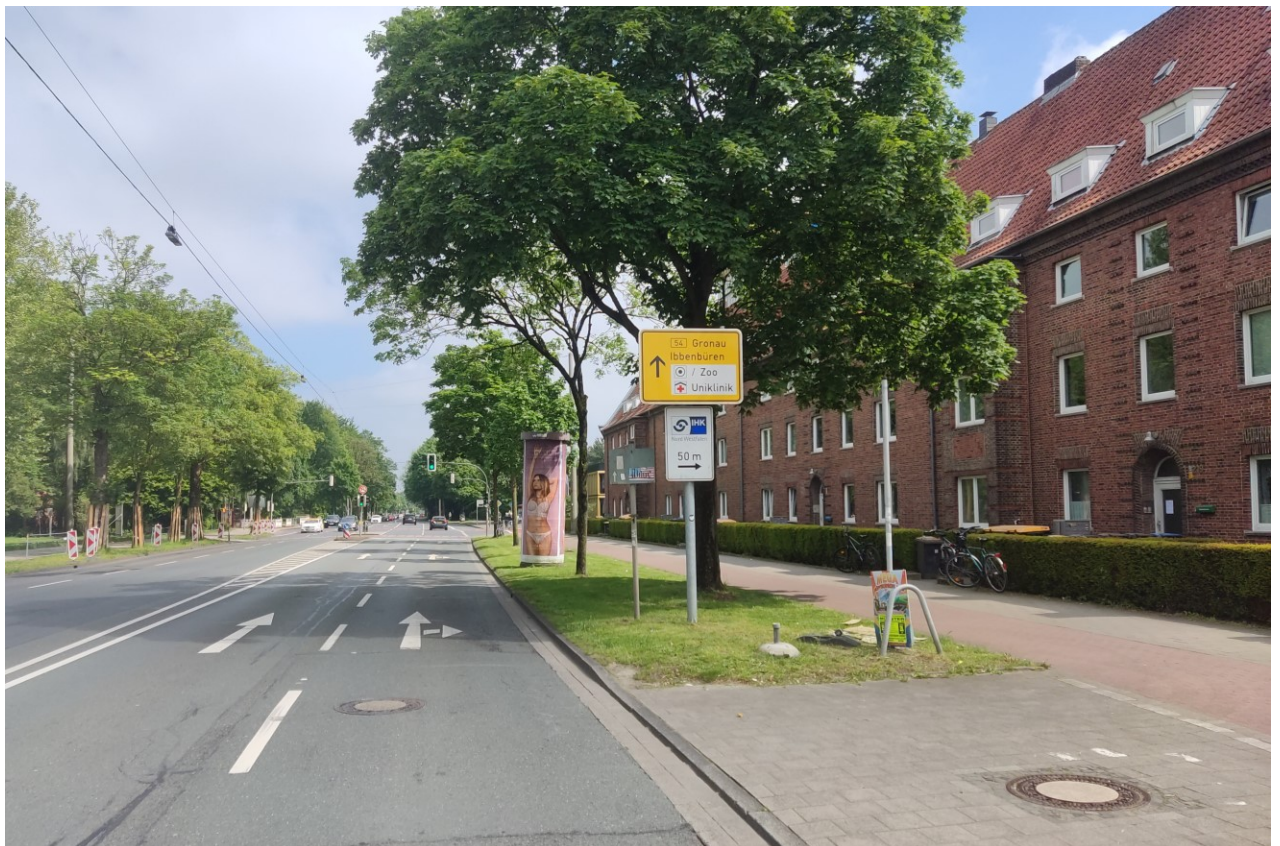
Abbildung 10: Weseler Straße stadteinwärts Höhe Hausnummer 219
