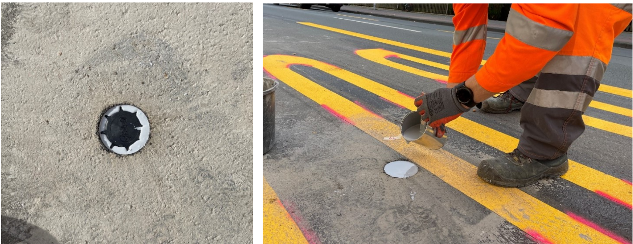
Abb. 1: Einbau der Bodensensoren innerhalb des Bussonderfahrstreifens
