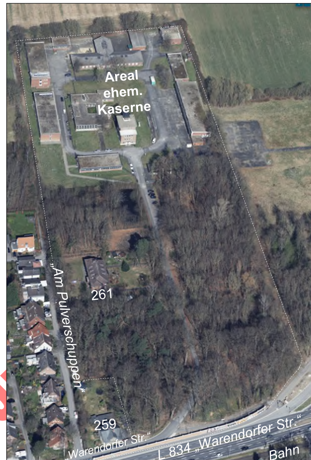
Abbildung 1: Schrägluftbild Richtung Norden
