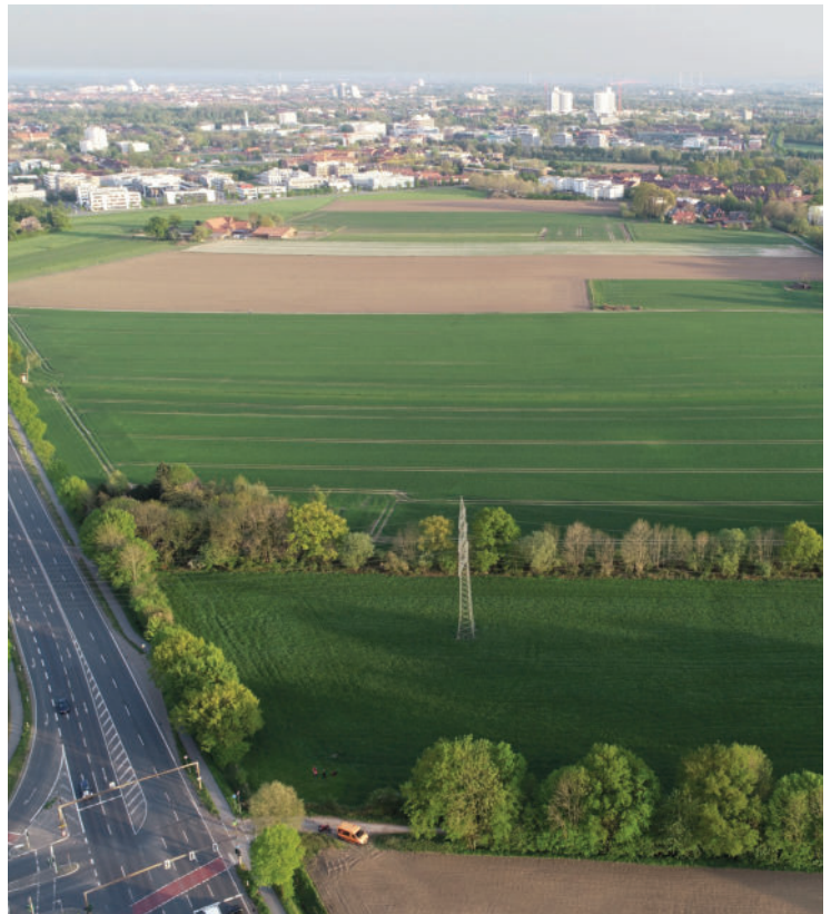
Hochspannungstrasse (Blick aus Norden)
