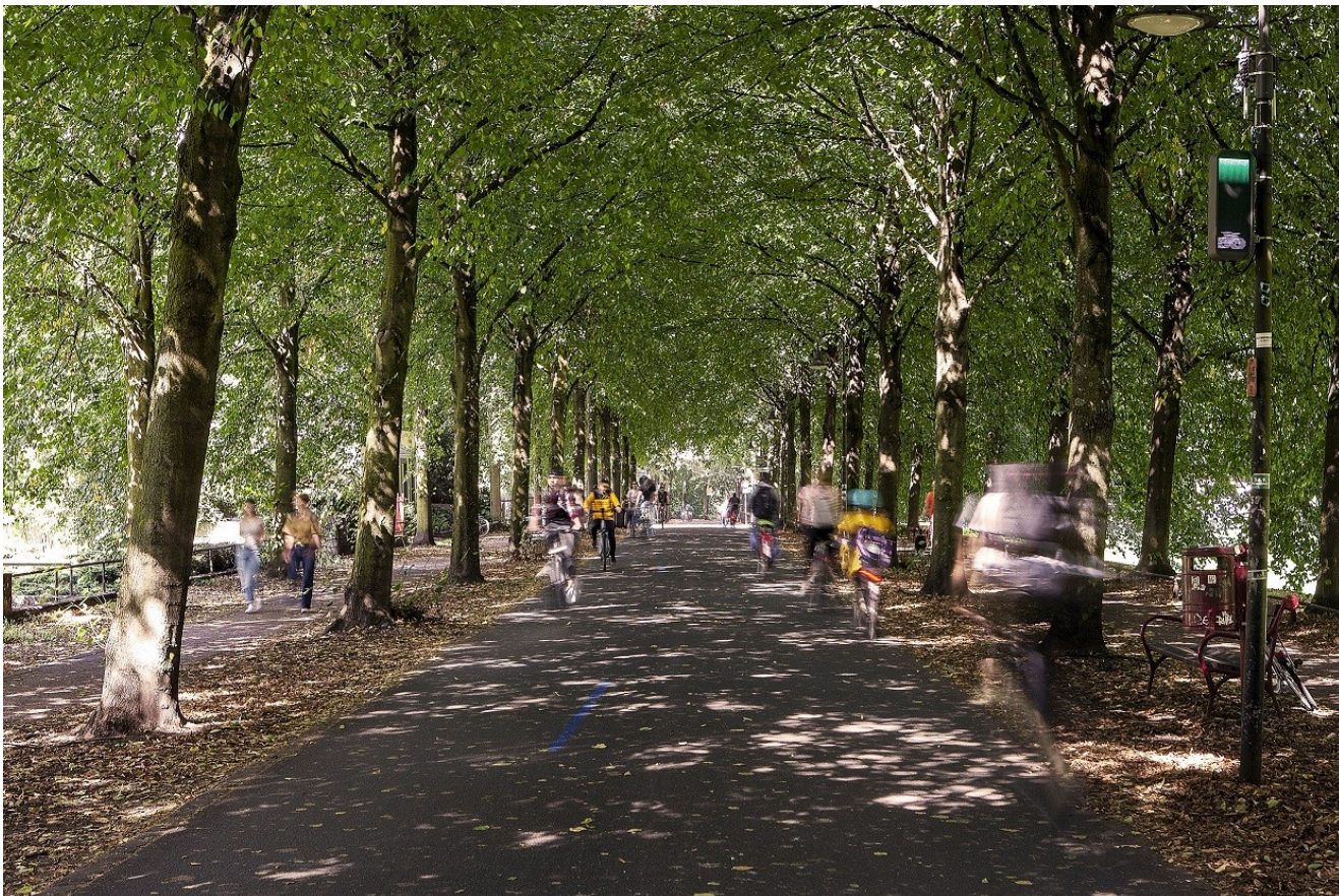
Leezenflow am Beleuchtungsmast auf der Promenade (Foto: Stadt Münster, Smart City)
