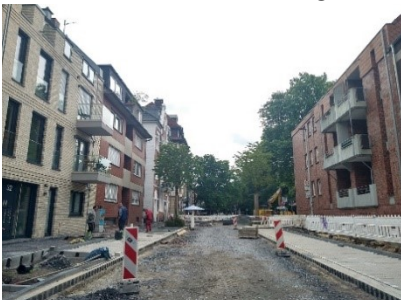
Abbildung 1: Bauabschnitt 1 der Wilhelmstraße Anfang Juli 2024 (Foto: Stadt Münster)
