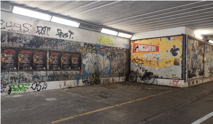
Aufweitung Eingang Ostseite
