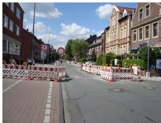
Abb. 24: Baustelle Bohlweg (zwischen Piusstraße und Beldensnyderweg)
