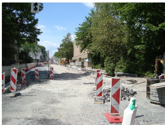
Abb. 23: Baustelle Bohlweg (zwischen Hörster Platz und Piusstraße)
