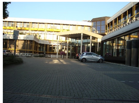
Abb. 30: Fertiggestellter Eingangsbereich der Kassenzahnärztlichen Vereinigung
