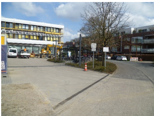
Abb. 29: Baustelle im Eingangsbereich der Kassenzahnärztliche Vereinigung 2021
