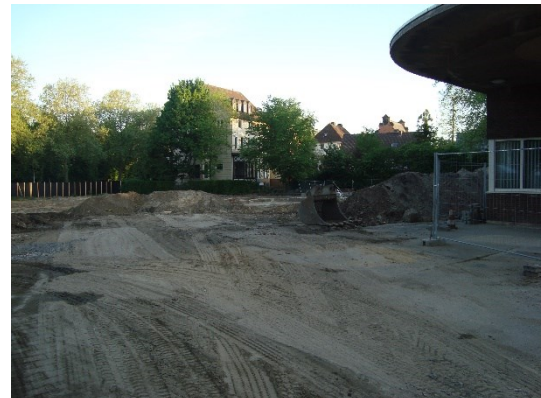
Abb. 28: Baustelle LWL-Parken (Karlstraße)
