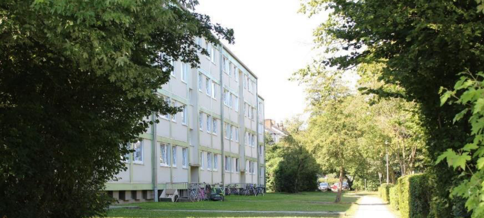
Bild 29: Geschosswohnungsbau in der Waldsiedlung
