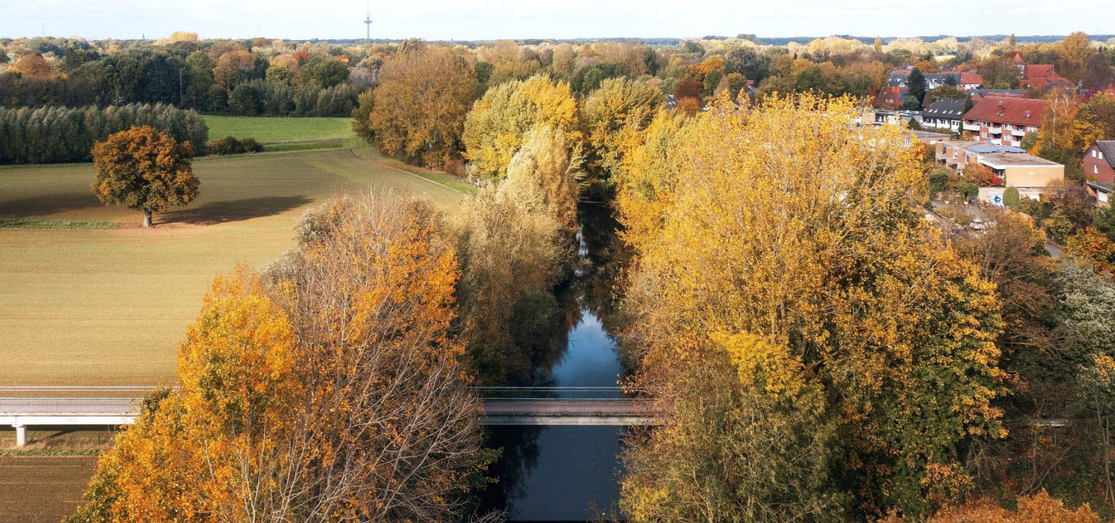
Bild 35: Blick über die Wersebrücke
