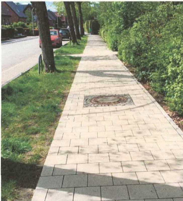
Abbildung 3: Neuer Gehweg ohne Schäden und ausreichend großen Baumscheiben
