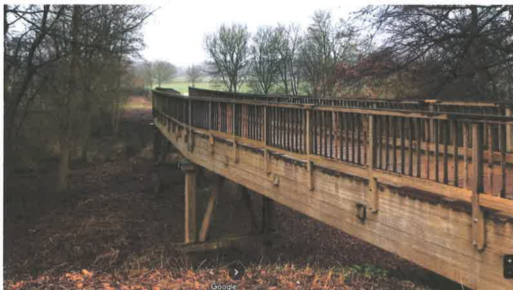
Alte Geh- und Radwegebrücke in der Haskenau über die Werse
