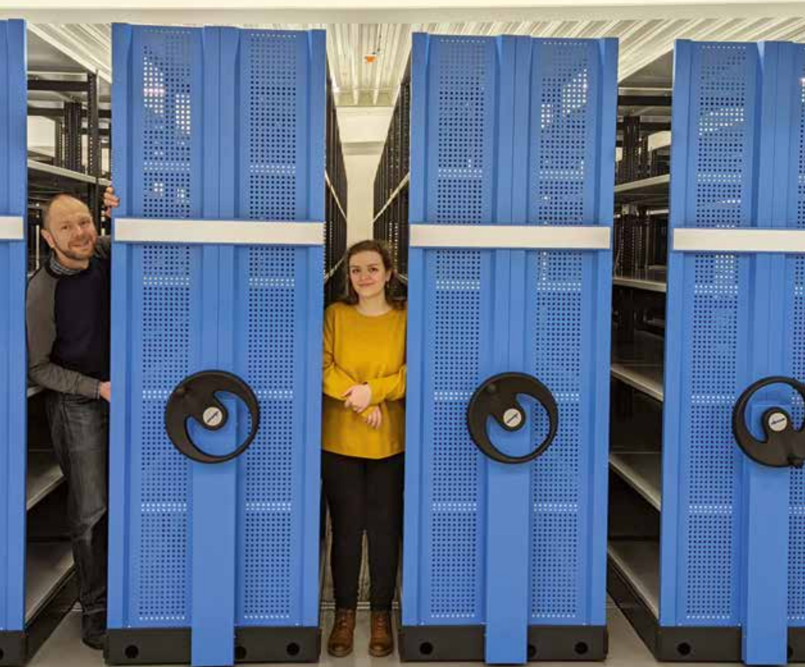
Inbetriebnahme der neuen Regalanlage im Speicher 15, Foto: Stadtarchiv Münster
