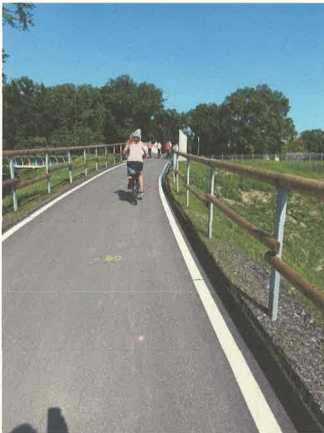
Neue Brücke „Jägersteg“
