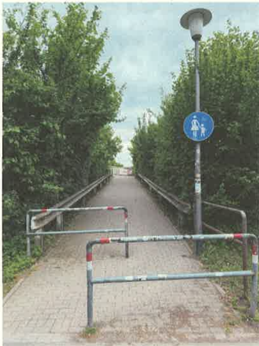
Brücke am Laerer Landweg
