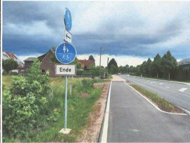
Ende der Ausbaustrecke in Richtung Münster
