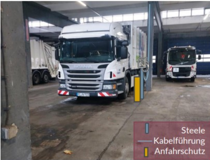
Abbildung 2: schematische Ausführung Ladeinfrastruktur in der Fahrzeughalle
