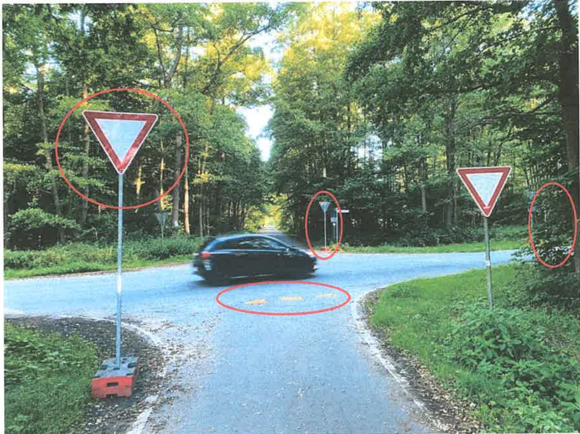
Bild 4: Auf diesem Bild aus der WN ist zu sehen, dass vor einiger Zeit temporär zusätzliche Schilder und Markierungen aufgebracht wurden (Foto: Stefan Flockert, Quelle: https://www.wn.de/muensterland/kreis-warendorf/telgte/kreuzung-sicherer-machen-3341500 )
