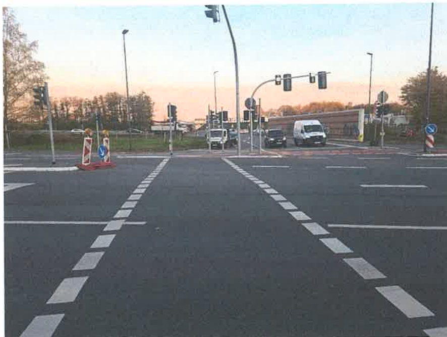
Blick von der südwestlichen Ecke über die Warendorfer Straße. Ausschließlich für Radfahrer aus der entgegengesetzten Richtung ist eine Lichtzeichenanlage installiert (im Hintergrund zu erkennen).
