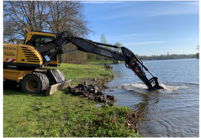
Abbildung 5: Entfernung von Uferverbau
