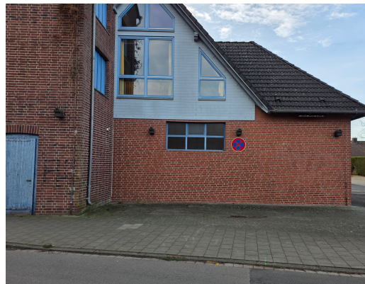
Abb. 3: Leerstehendes Feuerwehrgerätehaus Neuer Containerplatz vor Schlauchturm
