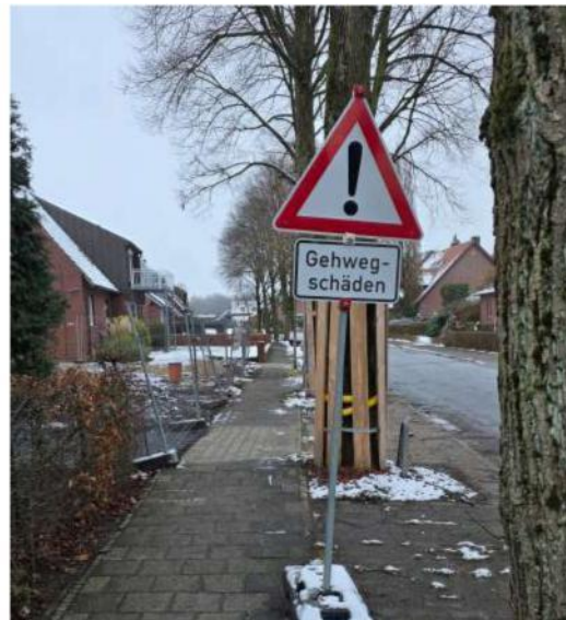
Aus Richtung „Kurneystraße“
