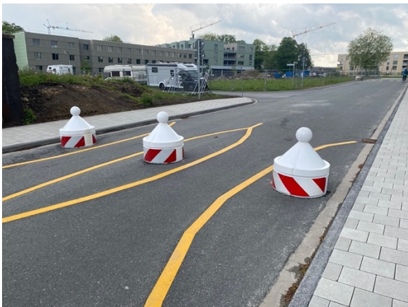
Sperrung der Gumprichstraße
