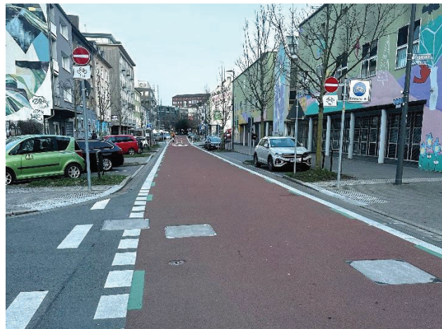
Abbildung 12: Markierung einer Veloroute in Dortmund
